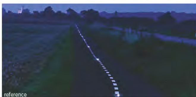
FIG. 44: REFERENCER BELÆGNING OG BELYSNING TIL CYKELSTI
